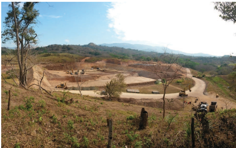
Figura 8. Construcción de una celda de disposición
