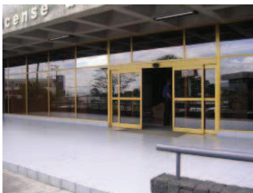
Fig.21 Ventanas, frente del edificio
