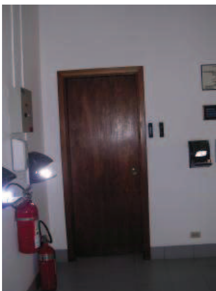
Fig. 40 Salida de emergencia
