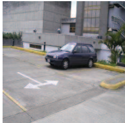
Fig.2 Costado sur del parqueo
