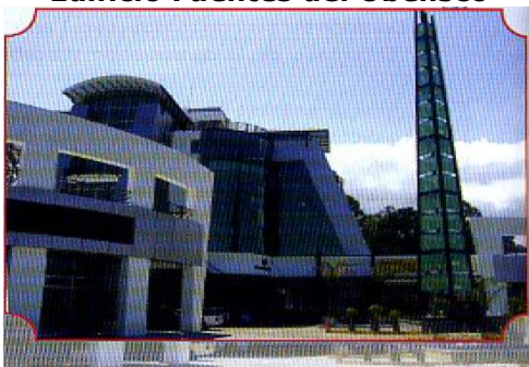
Figura 5 Edificio Fuentes del Obelisco
