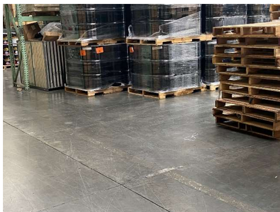
Ilustración 1. Condiciones del almacenamiento
